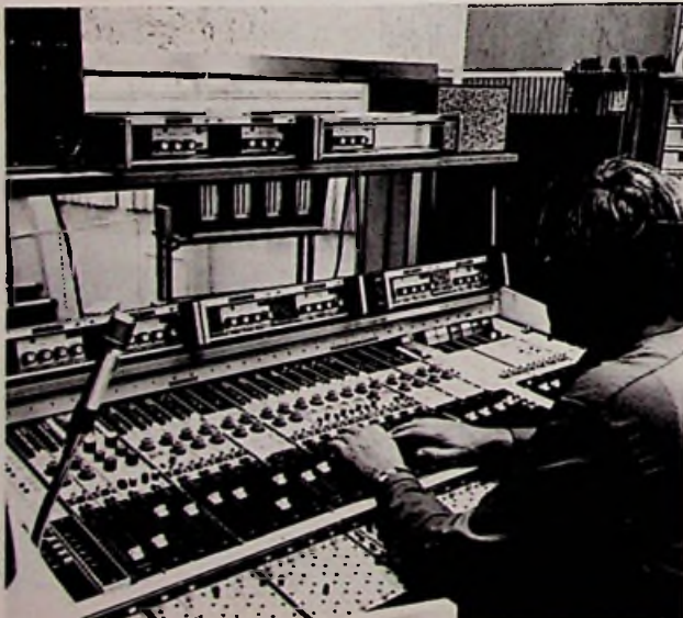
Afb. 1. De regeltafel in de controlekamer van Vara-2. Linksboven een octaaf-filter, daarnaast de Pye-limiters en een intercomluidspreker. Onder het blad is zichtbaar de acht-voudige modulatiemeter. In de tafel onderscheidt men twee maal acht microfoonkanaal cassettes, waarvan sommige van kanaalbegrenzers zijn voorzien. Behalve via een centraal verbindingspaneel, kunnen de kanalen worden gekozen met magneetschakelaars (reed-relais) voor de betreffende kanaalcassettes. De beide mix-mobielen zijn niet zichtbaar.
